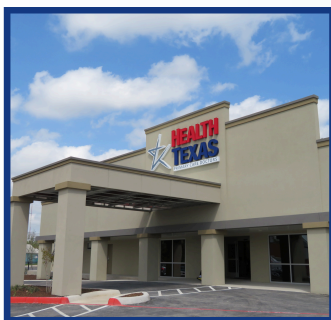
San Pedro clinic 530 San Pedro Ave San Antonio, TX 78212 (210) 225-4511
